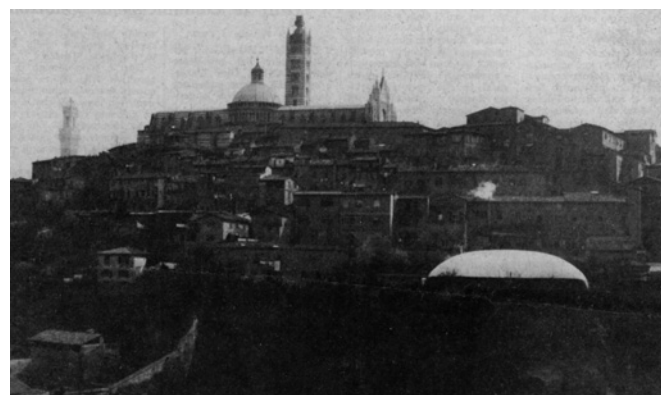
1976. Il Pallone del Costone, come appariva nel contesto del panorama senese. La struttura fu rimossa su disposizione del Comune.
